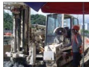
Il datalogger JET 4000 AME / J beneficia di una nuova scheda elettronica che permette di controllare la velocità di rotazione e di traslazione dell'asta per le applicazioni CFA e jet-grouting
