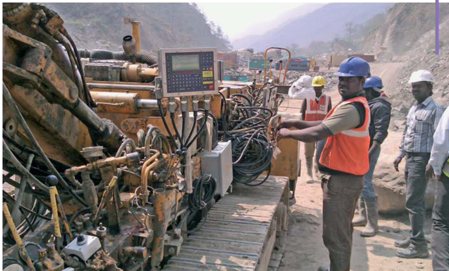
In Bhutan DAT instruments ha dato il proprio contributo per il cutoff di una diga: una serie di pali che andranno a formare una paratia al di sotto della diga stessa.
