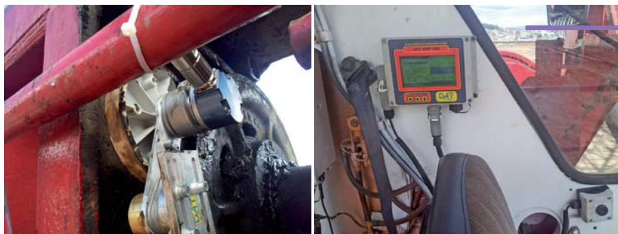
Nel contesto della metropolitana di Quito, in Ecuador, il lavoro ha previsto la creazione di pannelli di diaframma per definire il perimetro di una stazione. Per questo lavoro DAT instruments ha messo a disposizione un datalogger JET DSP 100 / D corredato da vari sensori di profondità, di inclinazione, di deviazione e di rotazione.
